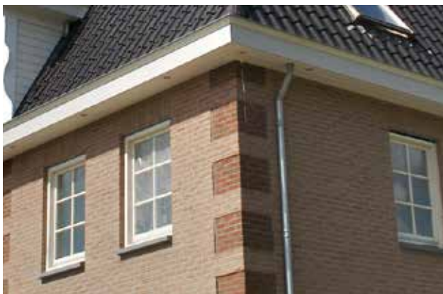
Metselwerk is dominant, incidenteel stucwerk mogelijk
